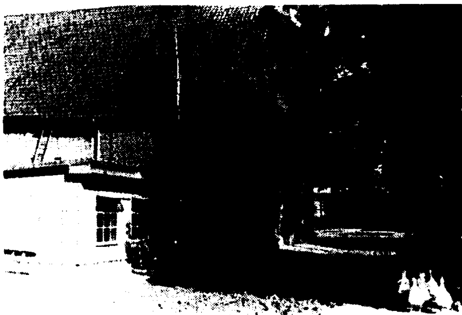
Abb.550 (19) Blick von der neuen Scheune (1938) nach Osten auf den gerade fertigen Hühnerstall (10x6 m, Zwischenraum der Bretterwände zur Isolation und gegen Mäuse und Ratten mit Gerstengrannen ausgestopft; Blechdach); dahinter der Speicher, weiter links der Pferdestall...
